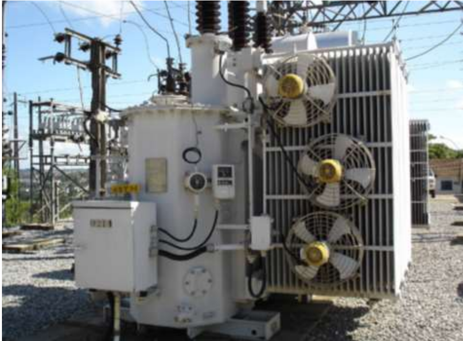
Figura 3. Subestação ao tempo
