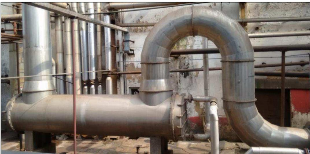
Figura 23 – Trocador de calor casco tubo instalado (Fonte: Elaborada pelo autor, 2016).
