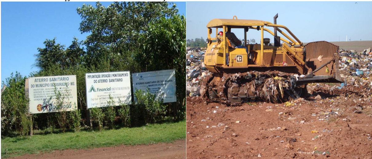
Figura 01 e 02: Identificação e funcionamento do aterro sanitário
