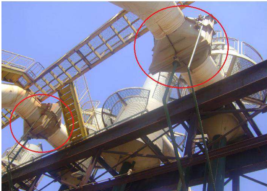
Figura 39. Separadores de arraste na tubulação dos condensadores barométricos. Fonte: Autor.
