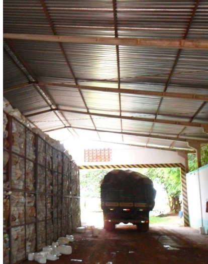
Figura 9: Área de descarga de embalagens vazias de agrotóxicos Fonte: Foto do autor
