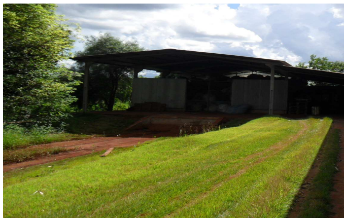
Figura 20: Ao fundo, área de expedição dos fardos Fonte: Foto do autor
