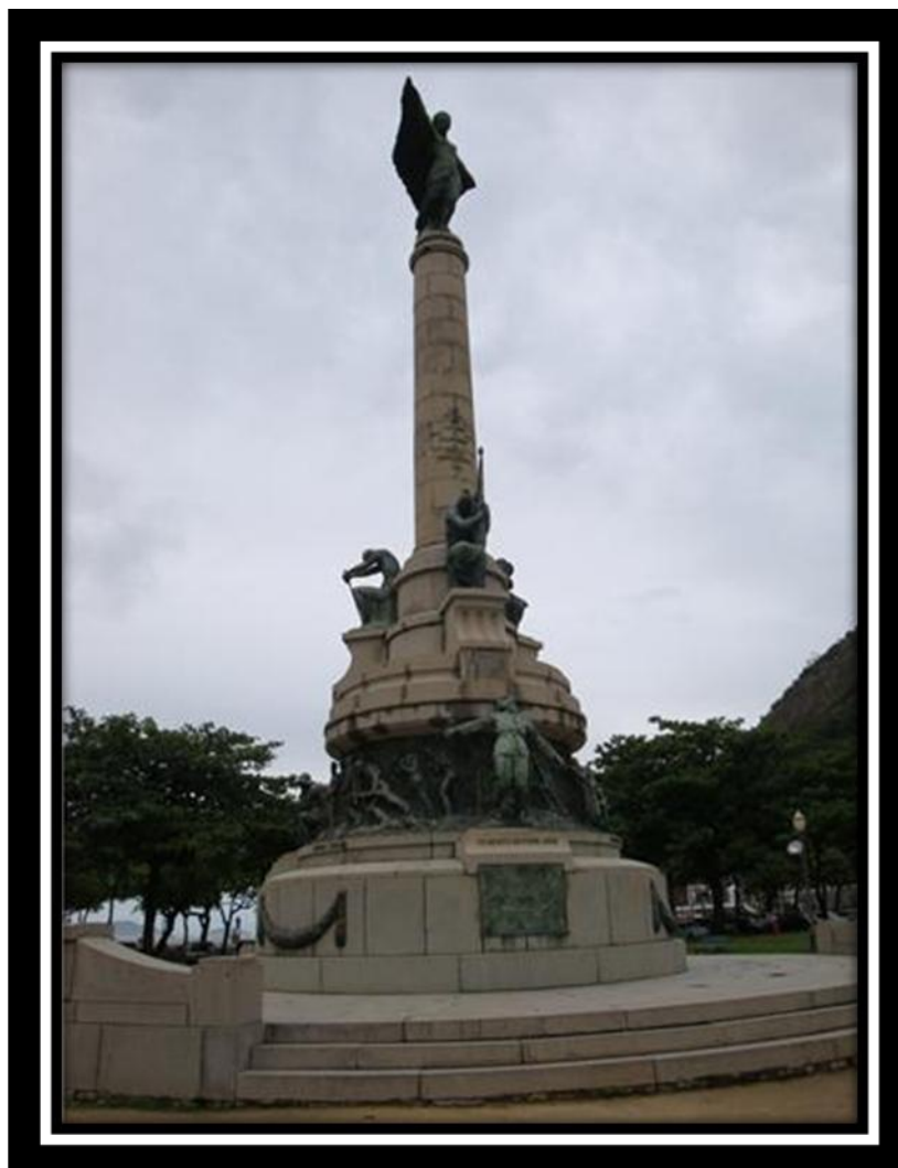
Fotografia 1 – Monumento aos Heróis da Laguna e Dourados . Rio de Janeiro/RJ - Vista geral.
