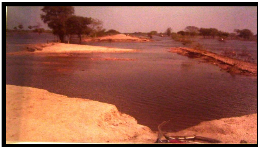
Foto 13 - Erosões causadas na BR 267 devido à enchente de 1982.
