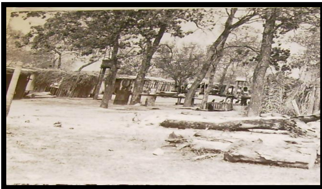
Foto 7 - Barracos improvisados no km 08 na enchente de 1982.
