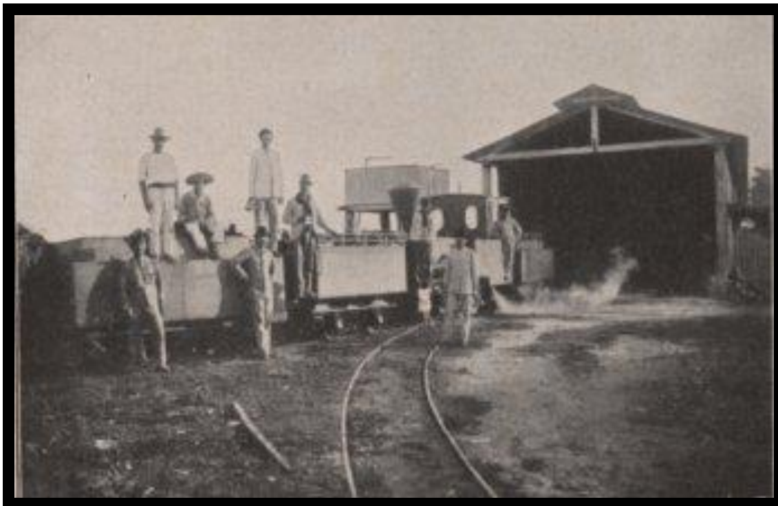
Foto 01 - Linha ferroviária construída pela Cia Mate Laranjeira na Fazenda São Roque
