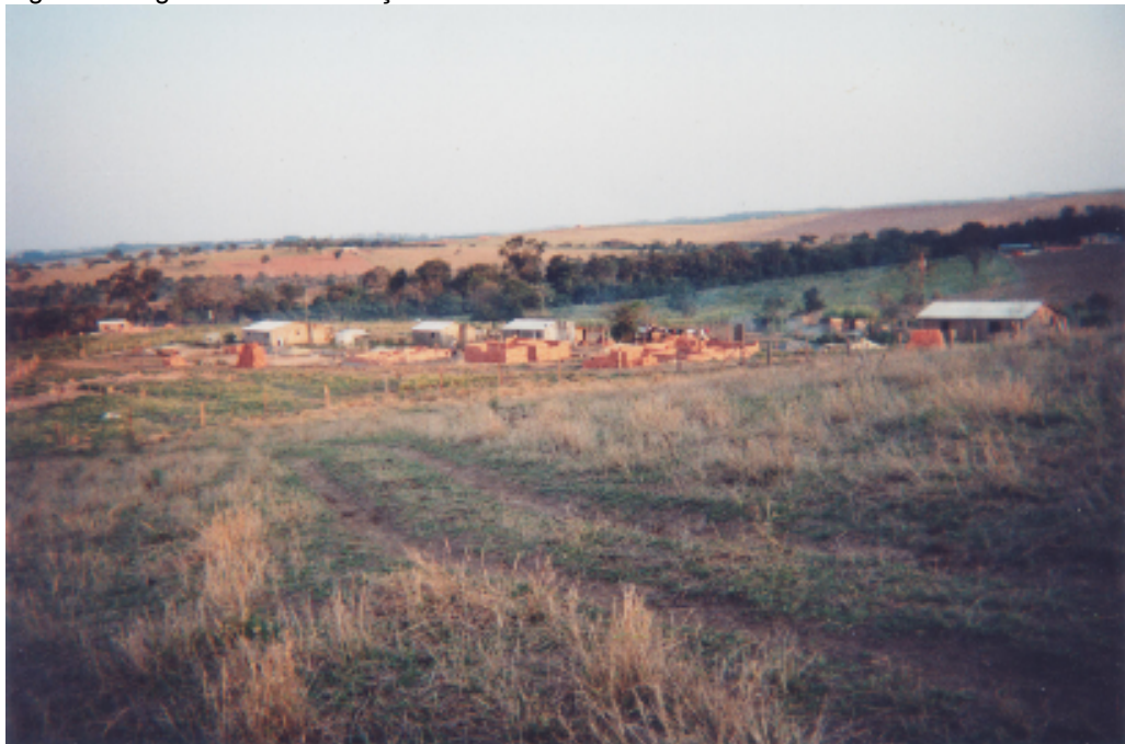
Figura 20: Agrovila em construção
