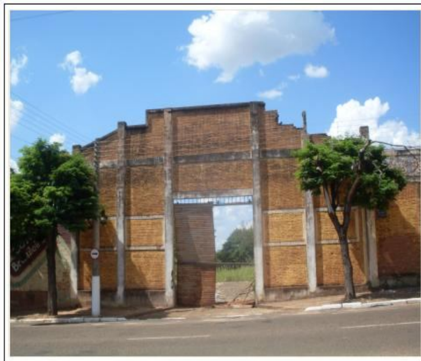
Figura 24 – Ruínas da Antiga Máquina Yoshioka Fotografia: Joviano, C. V. M em 23/11/2008
