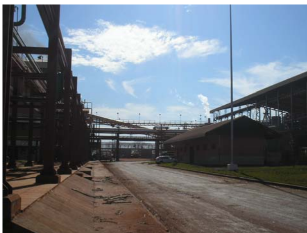
Figura 8 – Planta Industrial da Usina Eldorado. Foto: AZEVEDO, J.R.N. de (2007).
