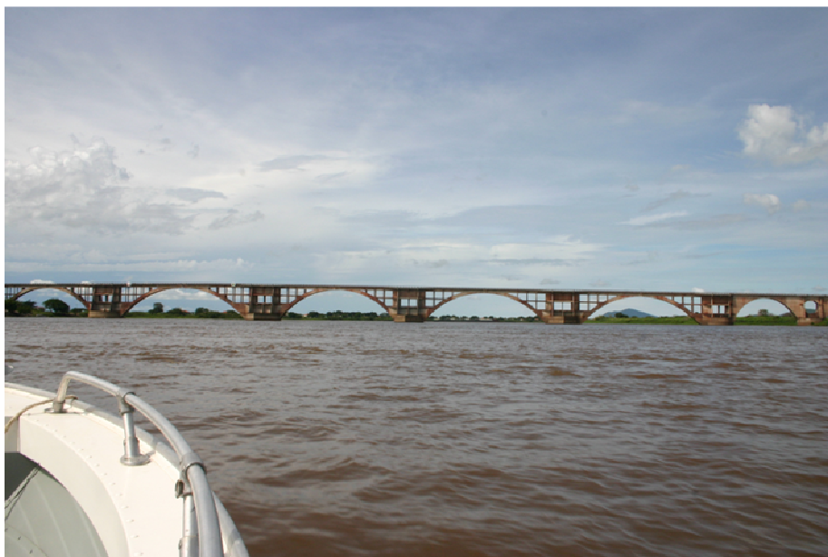
Foto 01: Ponte Ferroviária em Porto Esperança
