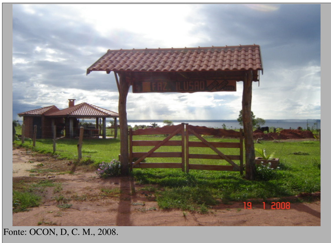
Foto 13 – Chalé, localizado no loteamento da Fazenda Lazer II
