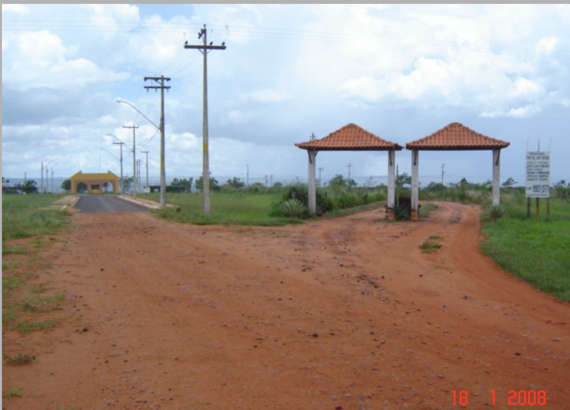
Foto 10 – Entrada da Pousada Portal das Águas
